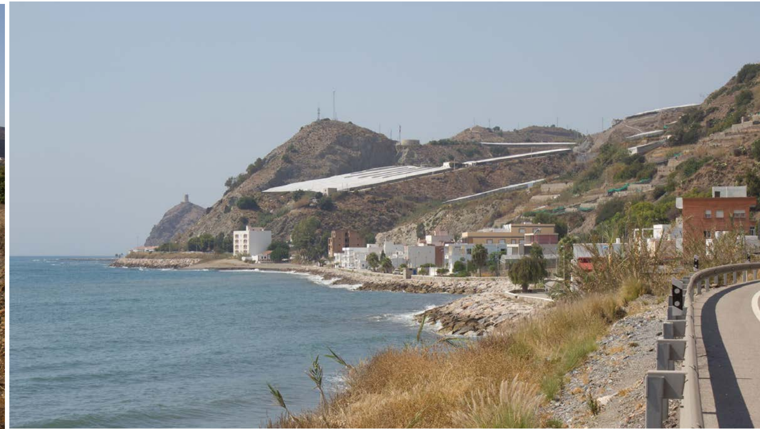
Foto 151. La miscelánea de usos del suelo se agudiza en los tramos de costa más recortados, donde el espacio para las ocupaciones urbanas y agrícolas es más reducido, provocando escenas visuales desordenadas y de baja calidad paisajística. En la imagen, un tramo del litoral más occidental de este tipo comarcal, entre Los Yesos y El Pozuelo (Granada). Autor: Ricardo Aussó Burguete.
