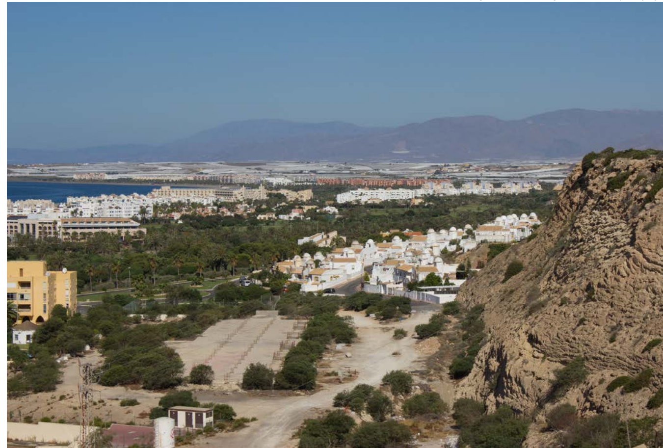
Foto 138. Junto a la plastificación del territorio, la expansión periurbana de las localidades de mayor atractivo turístico, caso de Roquetas de Mar, es uno de los principales conflictos que subyace en este territorio.
