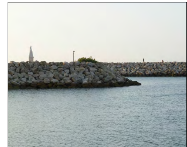
6. Escolleras de la bocana del puerto.
