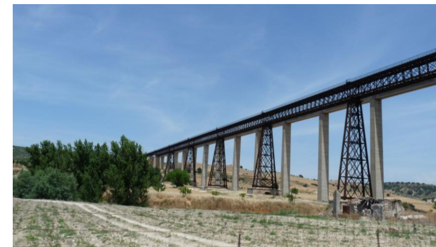
Puente del Hacho. Autores: M. Carmona y L. Porcel
