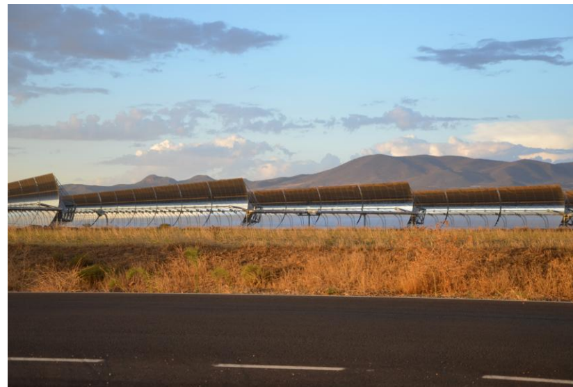
Detalle de las placas solares en el llano del Marquesado. Autores: M. Carmona y L. Porcel
