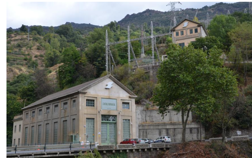
Central Hidroeléctrica Pampaneira. Autores: M. Carmona y L. Porcel
