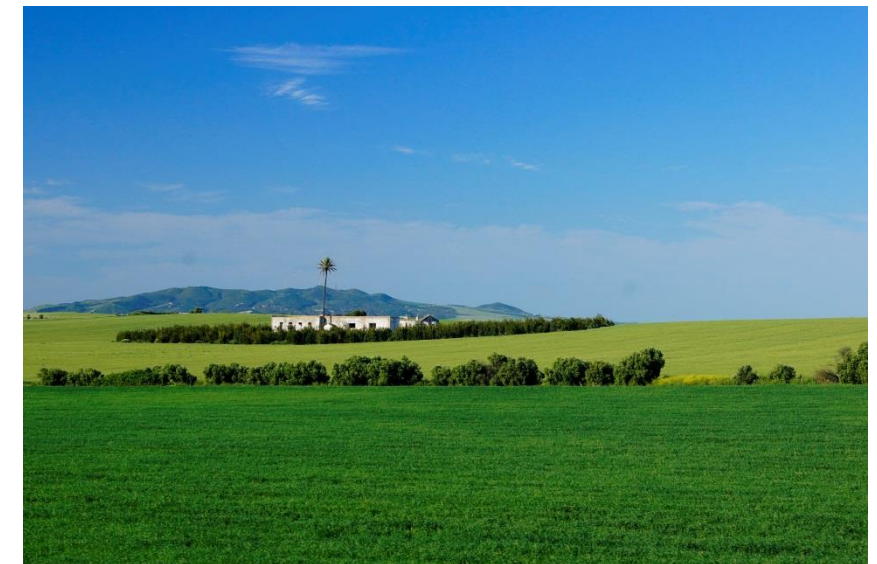
Foto 5. Edificación rural abandonada cerca de Torre Melgarejo. Autor: Rafael Medina Borrego.
