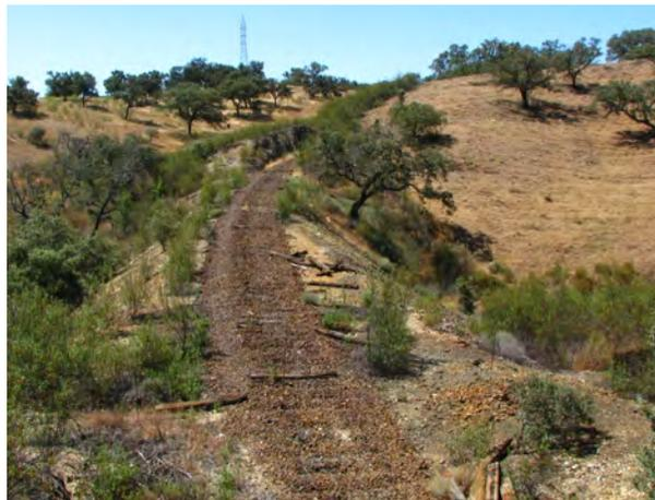
Foto 15: Línea de ferrocarril desmantelada de las Minas de Riotinto, dirigida al puerto de Huelva. Villanueva de las Cruces, Huelva.
