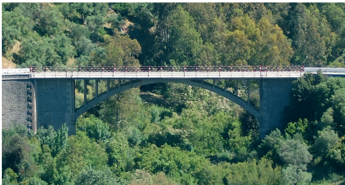
La carretera A-8126 y la Vía Verde de la Sierra comparten las vistas del valle del Guadalporcún.
